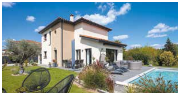
Construction de maison ⇒ Chaponost
